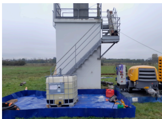
Photo d'une opération de régénération sur un forage
